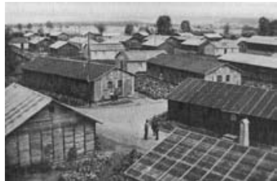
Büren an der Aare, Internierten und Straflager, 1940 für 6000 Polen gebaut
