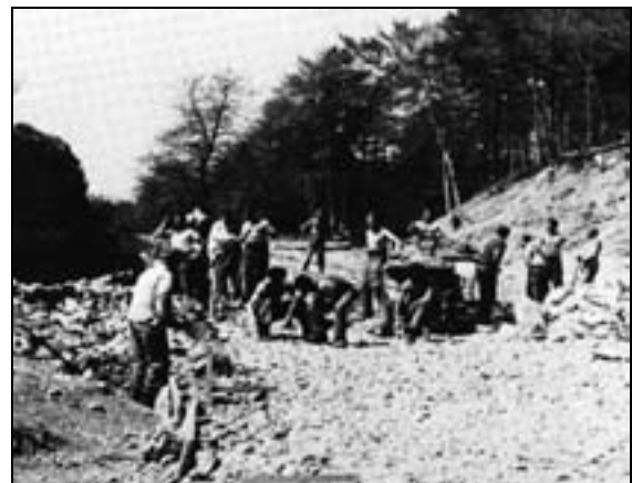
Strassenbau des Arbeitslagers Thalheim AG
