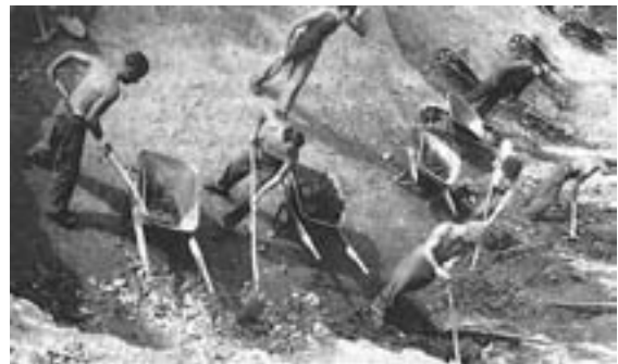
Der Bautrup aus dem Lager Bad Schauenburg (bei Liestal BL) erstellt eine militärische Verbindungsstrasse, Sommer 1940; Erlanger, S. 159
