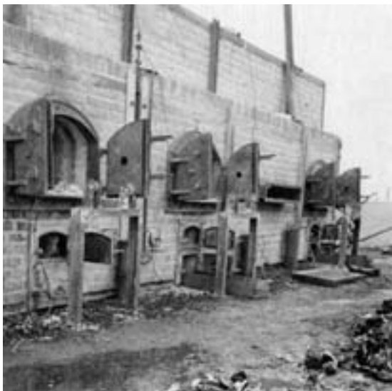
Verbrennungsöfen des Konzentrationslagers Majdanek, Aufnahme vom Juli 1944
